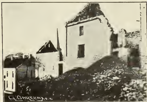
Fig. 110. Biesme. Maisons en ruines.
