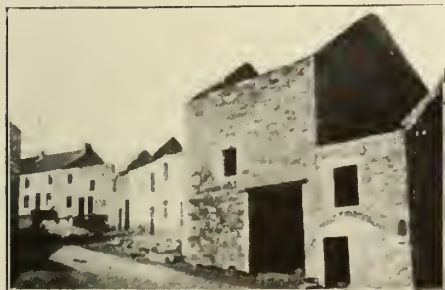
Fig. 111. — Oret. Maisons incendiées rue de la Citadelle.
